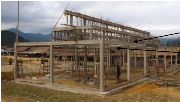
ຄານຫລັງຄາຕະຫລາດກະສິກໍາ ໄມ້ຄໍ້າທ້ອງຄານຫລັງຄາ(ຂາວັນຈຶ່ງສາມາດແກະແບບໄດ້)
