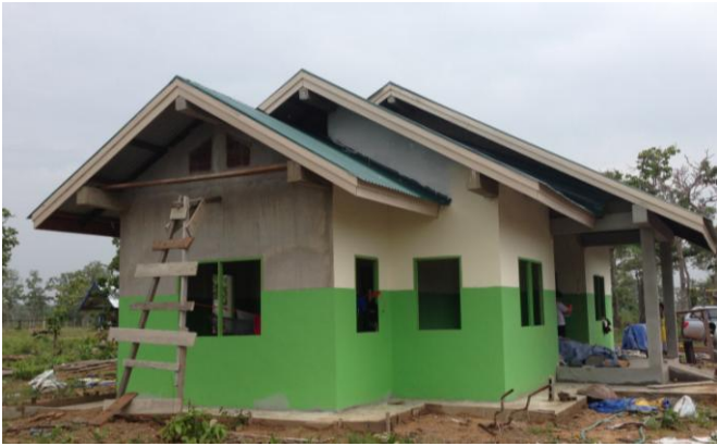
ການທາສີຝາ,ຕ້ອງໄດ້ຈັບລະດັບຄວາມສູງຂອງສີກັນເປື້ອນ (ສີຂຽວສີເຊັດໄດ້) ໃນລະດັບສູງ 150ຊມ,ຈາກນັ້ນດິດຝຽກໃຫ້ ເປັນເສັ້ນຊື່ທີ່ມີລະດັບຄວາມສູງເທົ່າກັນອ້ອມອາຄານ ທັງດ້ານນອກ ແລະ ດ້ານໃນຂອງຝາ ຈຶ່ງສາມາດທາສີໄດ້.
