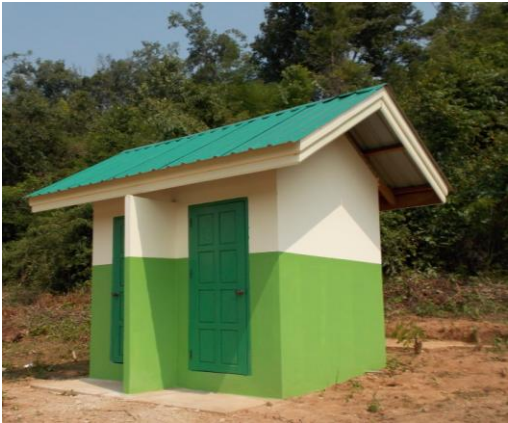
ການທາສີຝາ,ຕ້ອງໄດ້ຈັບລະດັບຄວາມສູງຂອງສີກັນເປື້ອນ (ສີຂຽວສີເຊັດໄດ້) ໃນລະດັບສູງ 150ຊມ,ຈາກນັ້ນດິດຝຽກໃຫ້ ເປັນເສັ້ນຊື່ທີ່ມີລະດັບຄວາມສູງເທົ່າກັນອ້ອມອາຄານ ທັງດ້ານນອກ ແລະ ດ້ານໃນຂອງຝາ ຈຶ່ງສາມາດທາສີໄດ້.
