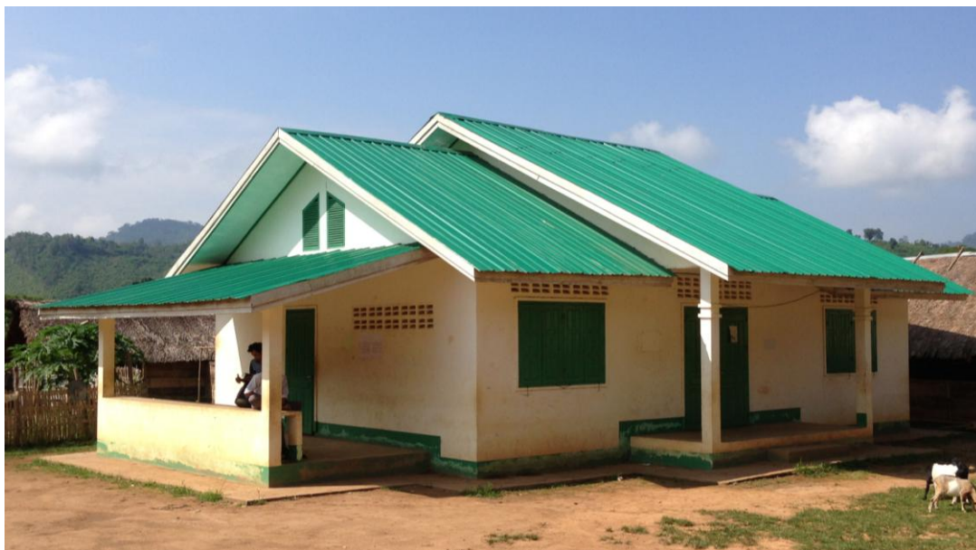
ສີຝາ, ສີກັນເປື້ອນລອກອອກ ແລະ ເປື້ອນເປົ ຈໍາເປັນຕ້ອງໄດ້ອະນາໄມ ແລະ ທາສີຄືນ
