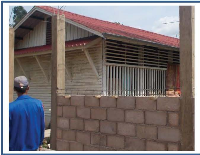
ການກໍ່ຝາທີ່ຖືກຕ້ອງ ຄວນໃຫ້ຊື່ ແລະ ພຽງດີ
