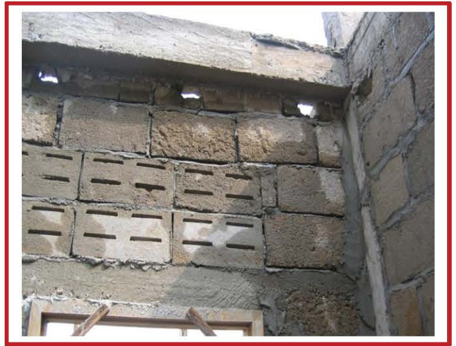
ການກໍ່ຝາທີ່ບໍ່ພຽງ ເຮັດໃຫ້ໂບກເປືອງຊີມັງ ແລະ ບໍ່ສວຍງາມ
