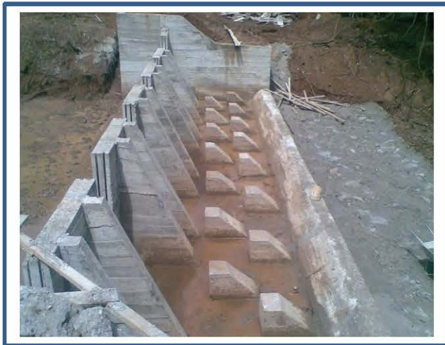
ອາຄານຫ້າຍຕ້ອງມີ ເພາະເປັນອ່າງຜ່ອນກຳລັງນ້ຳ
