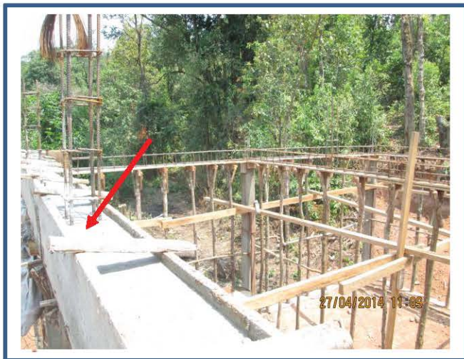
ການວາງເຫລັກເສົາທີ່ຖືກເຕັກນິກຕ້ອງໃຫ້ຢູ່ໃຈກາງຄານ
