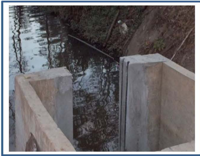
ໃສ່ສອງຮ່ອງ ເຮັດດ້ວຍເຫຼັກໂຕປ ເພື່ອຄວາມໝັ້ນຄົງ
