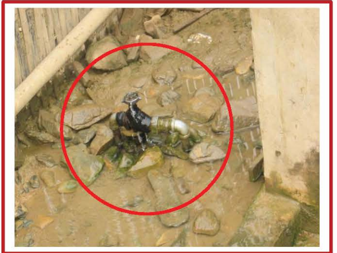
ບໍ່ຄວນປະລະເລີຍປະຕູນໍ້າລານກ້ອກແບບນີ້ ຖ້າຖືກລົບກວນຈະເຮັດໃຫ້ອັດຕາການໄຫລແຕ່ລະກ້ອກບໍ່ເທົ່າກັນ.
