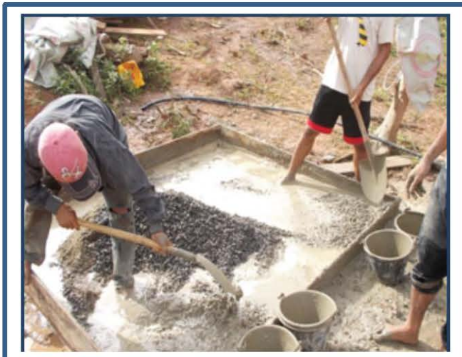
ຖ້າມີຄວາມຈຳເປັນຕ້ອງປະສົມດ້ວຍມືເນື້ອຈາກເອົາກິນຈັກເຂົ້າບໍ່ ໄດ້ ຄວນຕິຄອກ ເພື່ອບໍ່ໃຫ້ຊະຊາຍ
