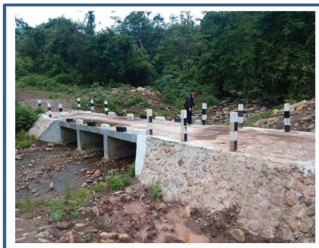
ດິນໃຕ້ຮາກຖານຂົວຕ້ອງມີຄາມແຂງແກ່ນ ແລະ ນໍ້າຊຶມຜານຍາກ
