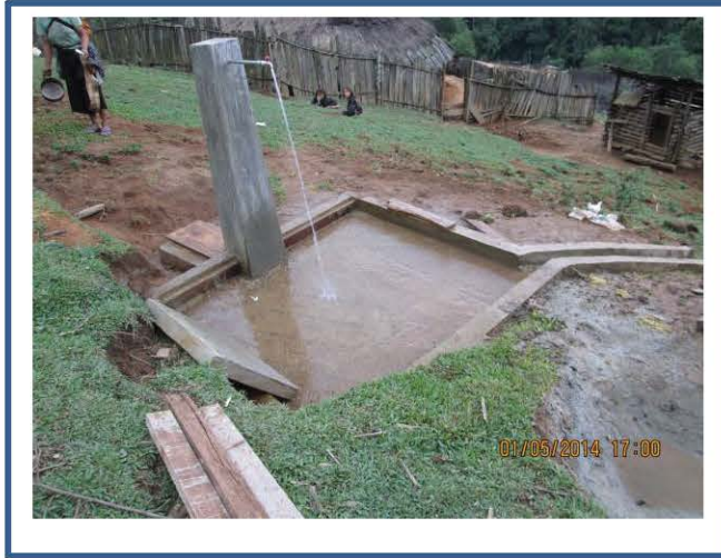
ການສ້າງຮ່ອງລະບາຍນ້ຳຕ້ອງໃຫ້ແທດກັບຫນ້າດິນ ແລະ ໜັ້ນຄົງ
