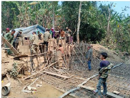
ການກໍ່ສ້າງຝາຍ ແລະ ອາຄານເອີນ້ຳເຂົ້າຄອງເໝືອງ
