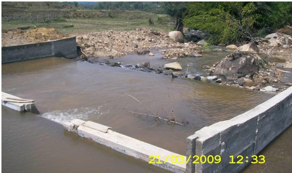
ຝາຍກັນນ້ຳ ສຳລັບເຮັດຊົນລະປະທານ ທີ່ກໍ່ສ້າງໂດຍຊຸມຊົນ ໂດຍການຊ່ວຍເຫລືອບາງດ້ານຈາກ ທລຍ
