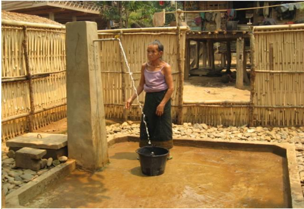
ລະບົບນໍ້າລົນ ທີ່ກໍ່ສ້າງໂດຍຊຸມຊົນ ໂດຍການຊ່ວຍເຫລືອບາງດ້ານຈາກ ທລຍ
